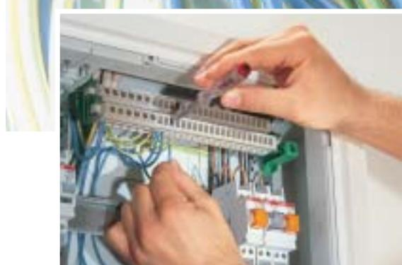
Гибкий провод без наконечника вставляется в зажим при помощи отвертки. Таким же образом провод отсоединяется от зажима.
